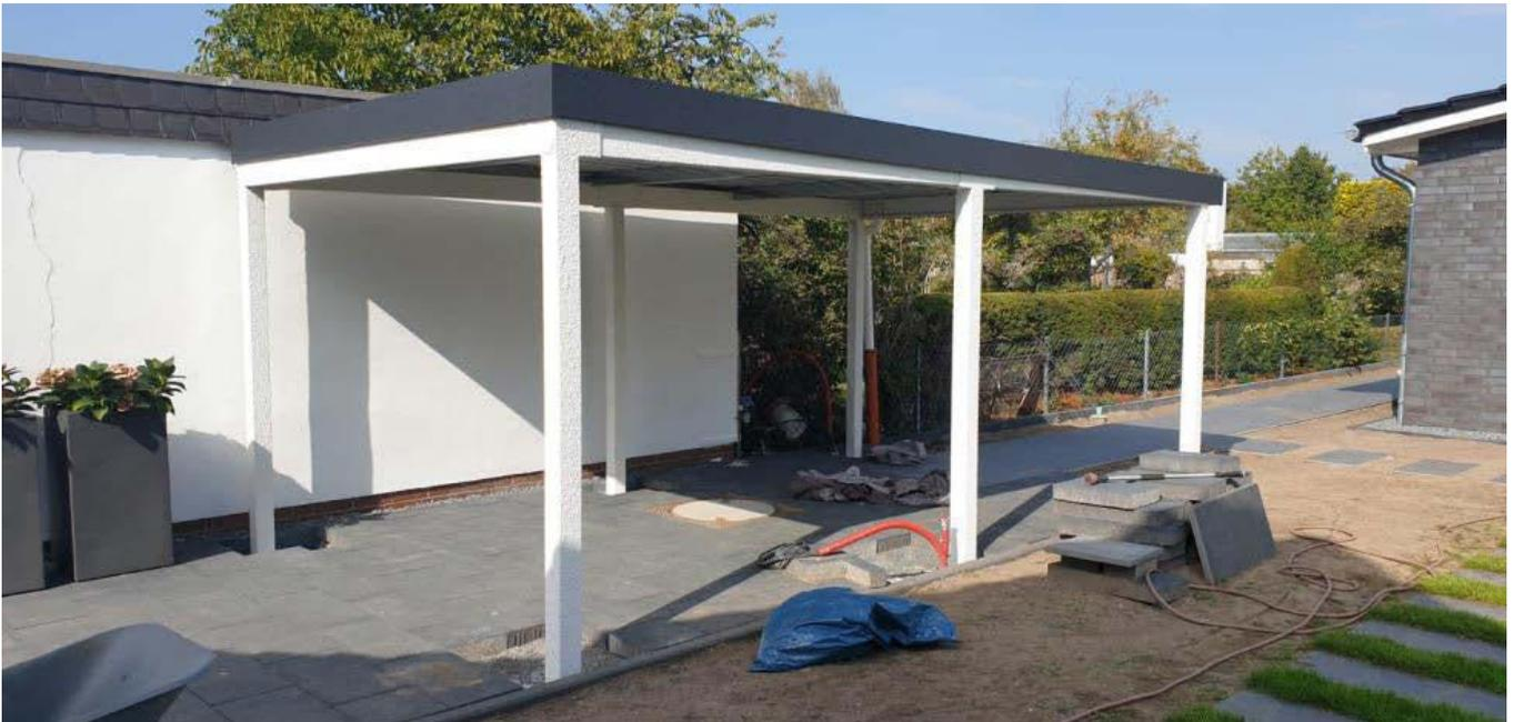
1.5. Die Löcher in dem Carportriegel für die Rückseite mit dem Kegelbohrer säubern und mit zwei Personen (einer rechts + einer links) hochheben und dann mit dem Längsträger rechts und links verschrauben. Das Gleiche mit dem Carportriegel für die Front.
