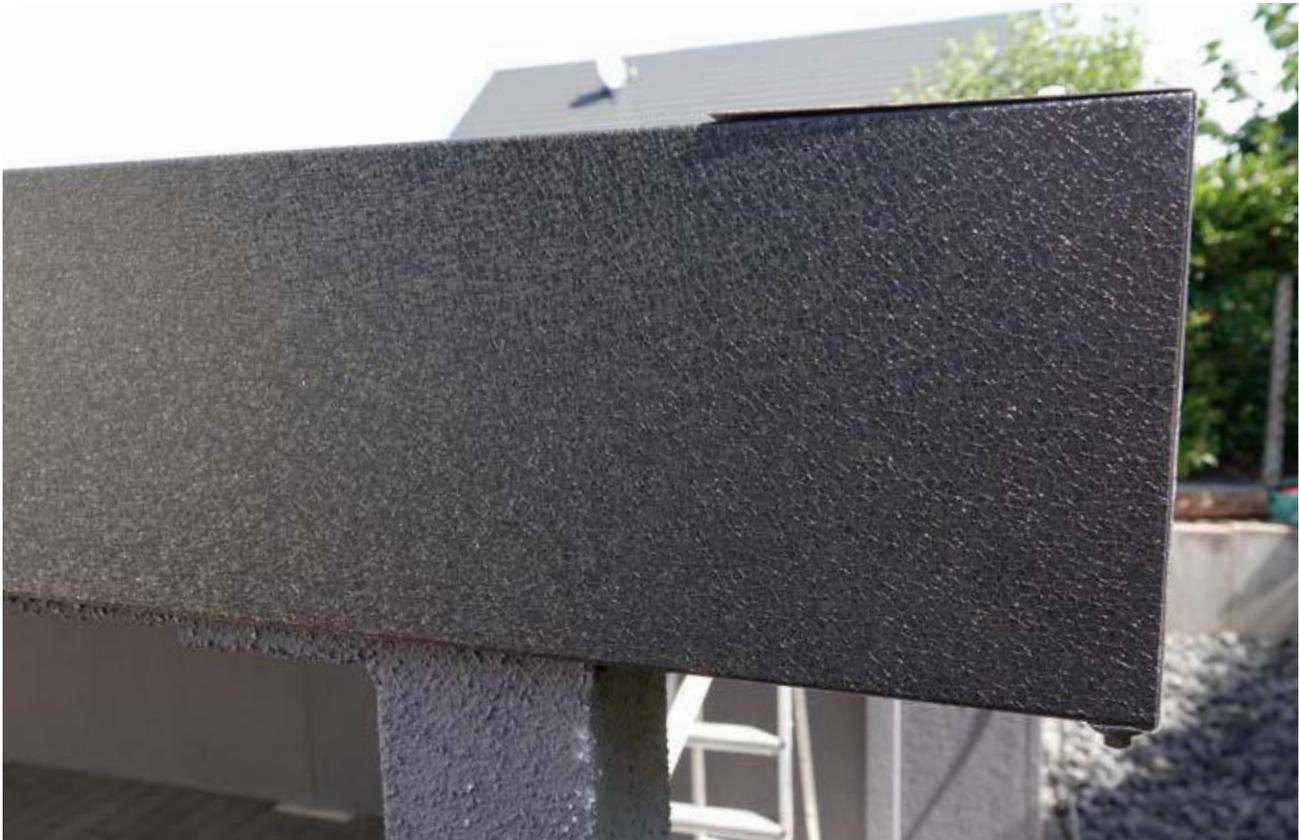
6.2. Eine Person muss jetzt auf das Dach steigen. Angefangen wird mit der Rückwandattika hinten links. Attika hochheben und in die Haken hängen. Eine weitere Person muss von unten die Rückwandattika festhalten. Der zweite Person unten nimmt die hintere linke schmale Seitenattika, hakt es seitlich bündig an und hält fest. Die Person oben auf dem Dach schraubt die Attiken auf den Hochsicken der Trapezbleche mit kurzen Schrauben an. Das gleiche für die rechte schmale Seitenattika hinten.
