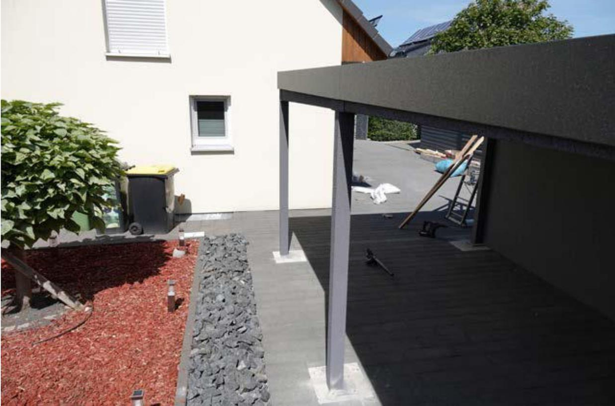
1.3. Längsträgerkonstruktion umdrehen und auf die Stützenfüße stellen – mit mehreren Personen stützen! Die Längsträgerkonstruktion vorne anheben und die mittlere Stütze mit U-Kant Profil von unten in der Mitte ansetzen und Längsträgerkonstruktion runterlassen, einstecken und verschrauben. Diese Konstruktion anschließend aufrecht bei Seite legen bzw. anlehnen. Den Vorgang für den zweiten Längsträger wiederholen.
