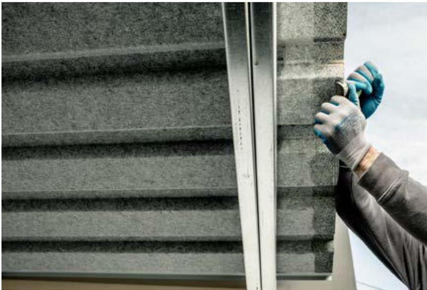
5.2. Von vorne mit der hohen breiten Hochsicke links bündig anfangend beginnen. Dach auflegen. Vorne muss das Dach 1,5 cm über dem Frontriegel des Dachkranzes drüberstehen. Hinten muss das Dachblech mit dem eventuell abgezogenen Vlies mittig in der Regenrinne stehen. Seitlich muss das Blech an der Außenkante des Längsträgers bündig angesetzt werden.
