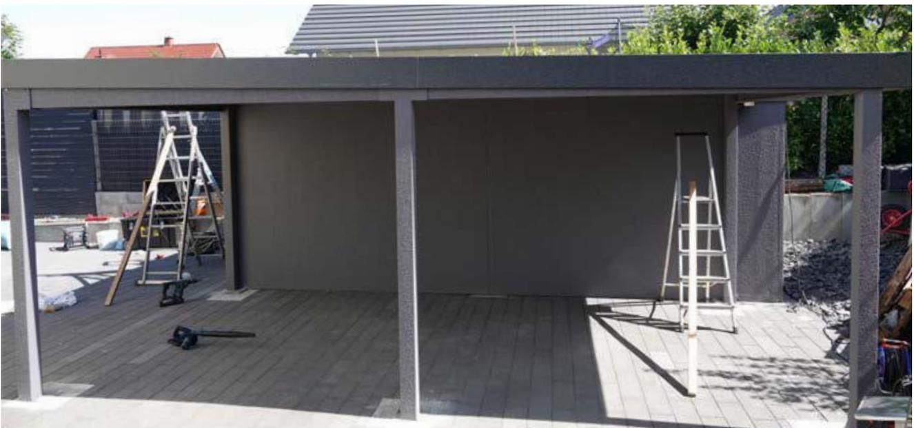
1.6. Prüfen, ob alles in Waage und Winkel steht und dann alle Schrauben festschrauben. Der Dachkranz ist somit fertigmontiert!
