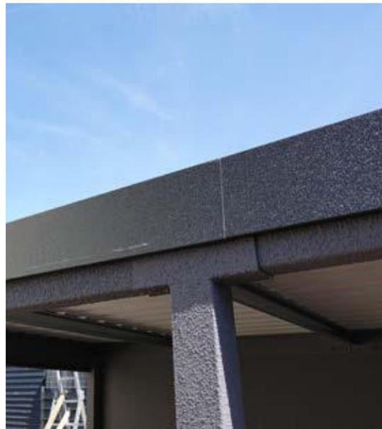
1.4. Beide fertigmontierten Längsträger mit Stützen aufrecht auf die Punktfundamente stellen und ausrichten. Nicht in dem Fundament verschrauben!
